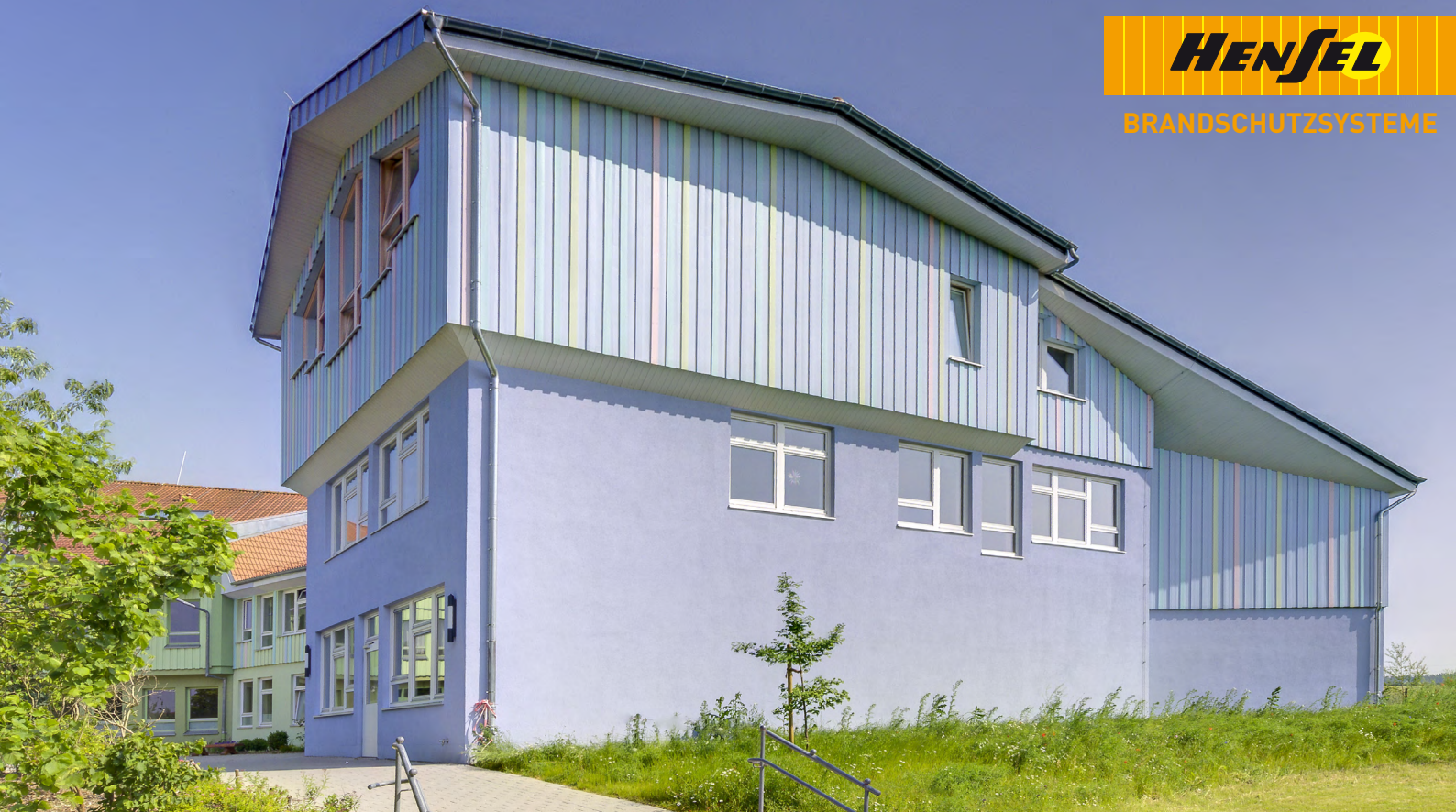
Holzfassade der Waldorfschule Wendelstein geschützt mit HENSOTHERM® 2 KS AUSSEN
